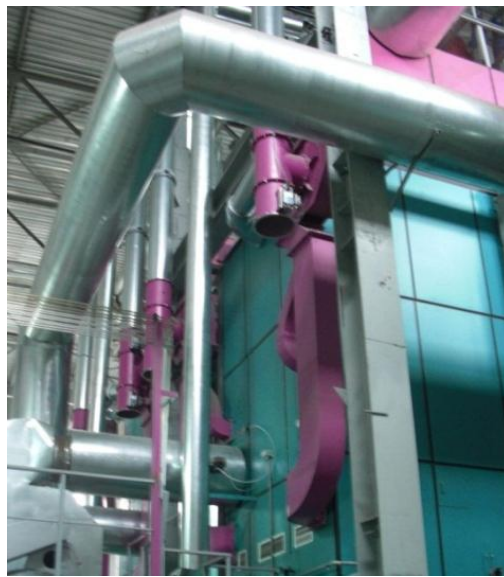
Рис. II-8 Система вторичного воздуха горения типа SLV
