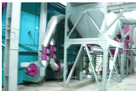
Рис. II-7 Прямоприводные вентиляторы первичного воздуха горения с односторонним всасом
