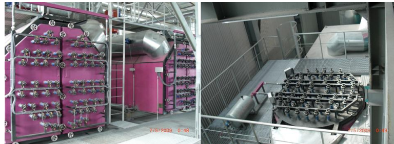
Рис. II-20 Система автоматической очистки сжатым воздухом
